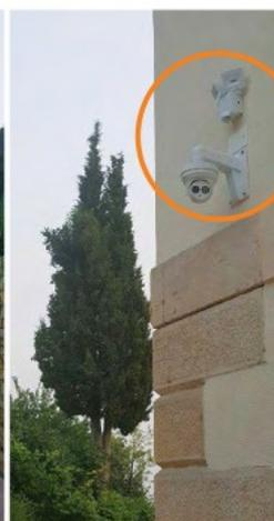
L'impianto video è composto da telecamere compatte Megapixel, installate all'esterno dell'abitazione e collegate a un NVR per la registrazione continua delle immagini. Queste ultime - grazie a un collegamento Web in ADSL - vengono trasmesse su smartphone, Pc e televisore di casa.
